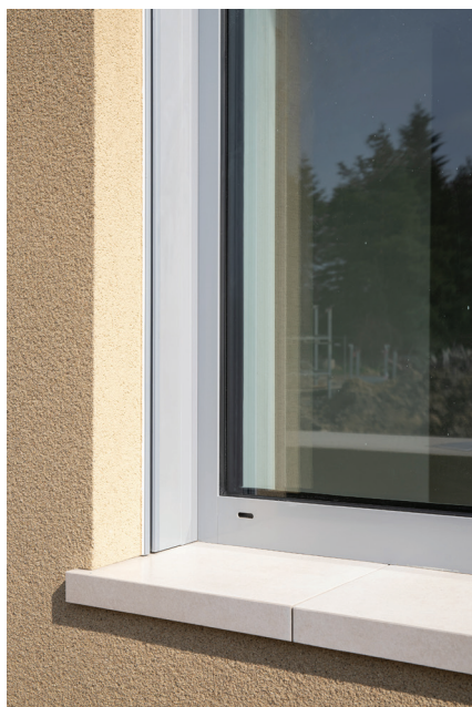
Integrované venkovní žaluzie Elektricky ovládané s kastlíkem umístěným v zateplení
