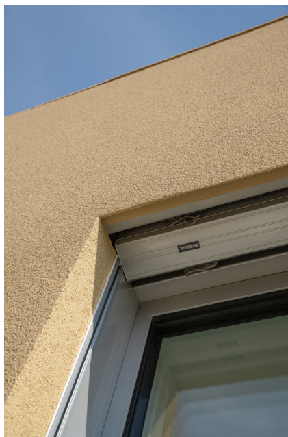
Integrované venkovní žaluzie Elektricky ovládané s kastlíkem umístěným v zateplení
